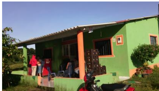
Ilustración 1. Paredes exteriores, Vereda El Triunfo
